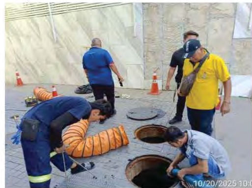
สูบล้างและกากไขมันระบบบำบัดน้ำเสีย
