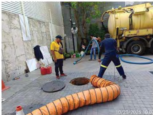
สูบล้างและกากไขมันระบบบำบัดน้ำเสีย
