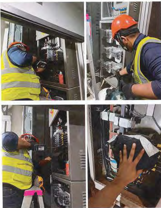
ภาพแสดงการบำรุงรักษาตู้เมนไฟฟ้า (DB PANEL & PLUG IN) ทำการตรวจเช็คสภาพทั่วไป กวาดล้างด้วยผ้าชุบน้ำหมาดๆ, ทดสอบความเป็นฉนวน และทดสอบความต้านทานลัดกั้น
