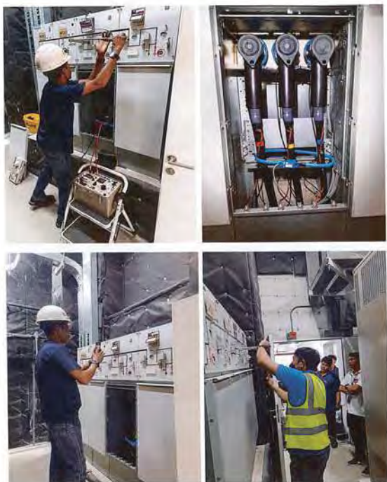
ภาพแสดงการบำรุงรักษา Ring Main Unit (RMU) ทำการตรวจเช็คสภาพทั่วไป
