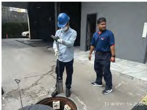
เก็บตัวอย่างน้ำทิ้งก่อนเข้าระบบบำบัดน้ำเสีย
