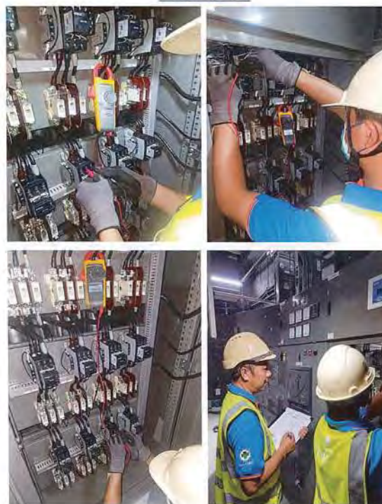
ภาพแสดงการบำรุงรักษา Capacitor bank ทำการตรวจเช็คสภาพทั่วไป, เทอร์มินัลต่อสาย, ทำความสะอาด
