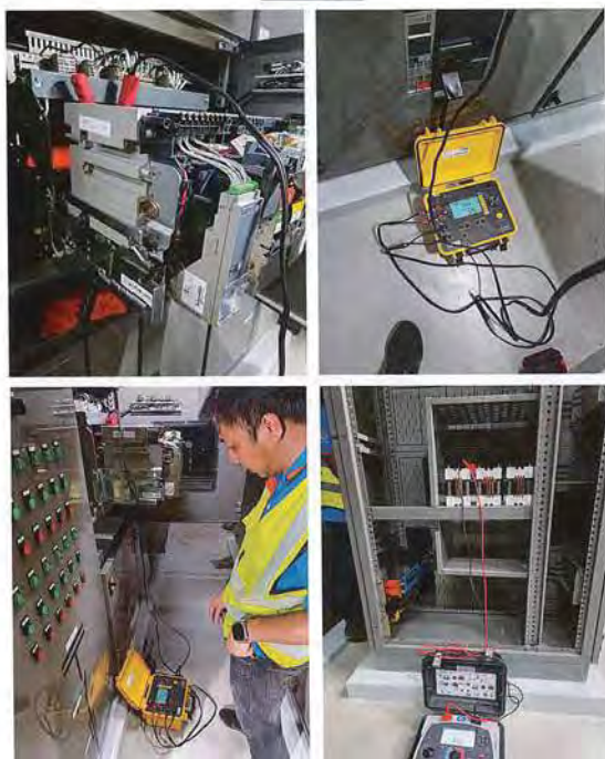
ภาพแสดงการบำรุงรักษา Air Circuit Breaker ทำการตรวจเช็คสภาพทั่วไป, ระบบรางเลื่อน, เทอร์มินัลต่อสาย จากนั้นทำความสะอาดและทดสอบส่วนเคลื่อนไหว เช่น กลไก, ฟันเฟือง, สปริง
