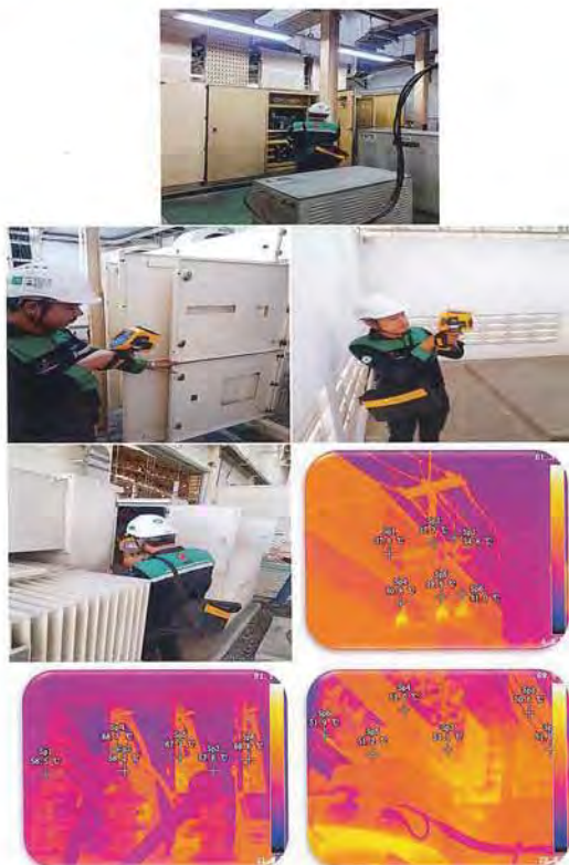
ภาพแสดงการถ่ายภาพความร้อนอุปกรณ์ไฟฟ้า ก่อน และหลัง ทำการบำรุงรักษาระบบไฟฟ้า
