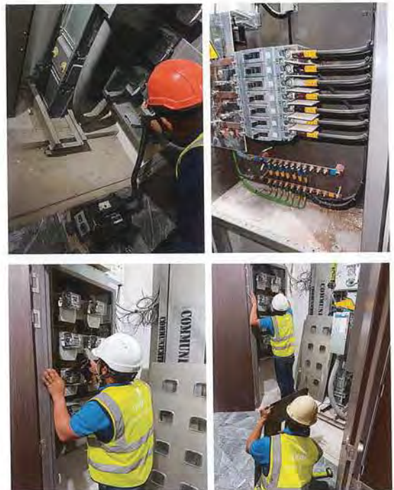
ภาพแสดงการบำรุงรักษาตู้เมนไฟฟ้า (DB PANEL & PLUG IN) ทำการตรวจเช็คสภาพทั่วไป กวาดล้างด้วยผ้าชุบน้ำหมาดๆ, ทดสอบความเป็นฉนวน และทดสอบความต้านทานลัดกั้น
