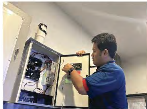
เจ้าหน้าที่ตรวจเช็คอุปกรณ์ป้องกันและแจ้งเหตุเพลิงไหม้
